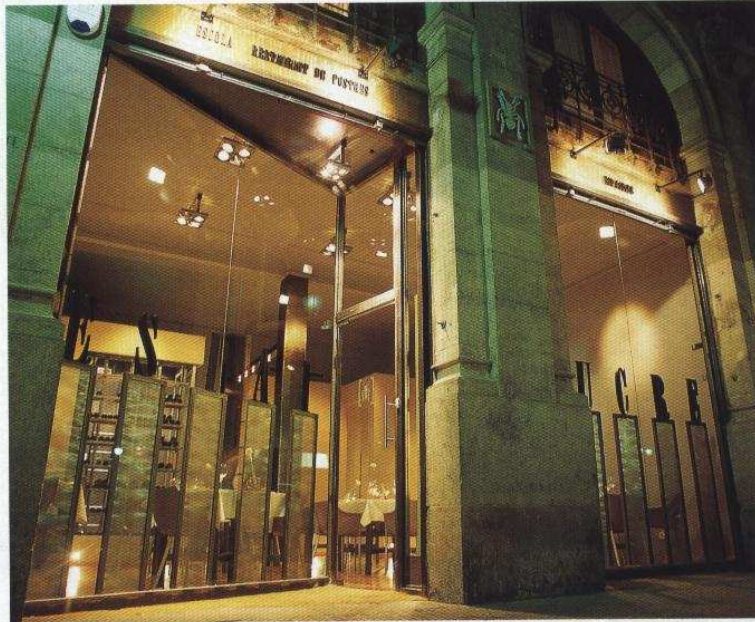
Fachada principal de Espai Sucre un nuevo punto de encuentro en Barcelona para los amantes del dulce y la gastronomía
